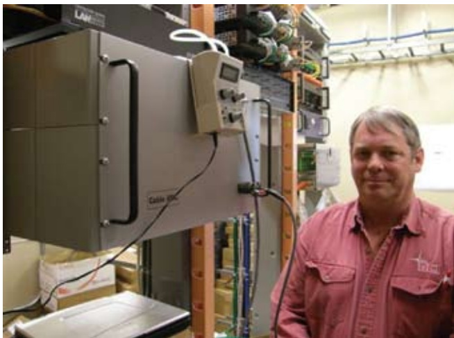
Rick Bates al finalizar la instalación del transmisor de Cable AML.
