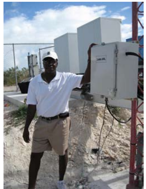
Herbie INGHAM durante la instalación de un repetidor de Cable AML
