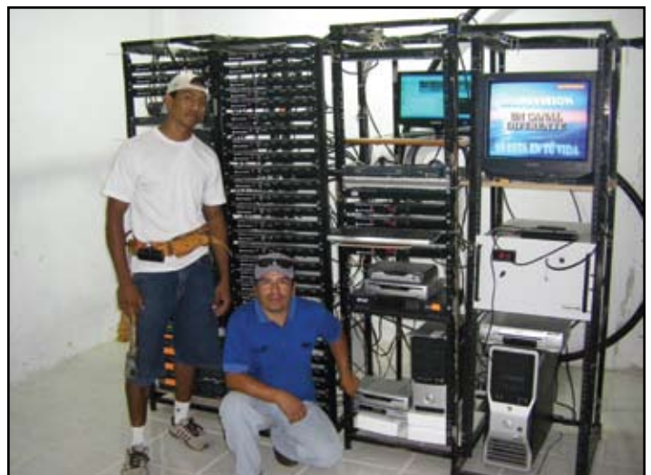
Técnicos de Cable Zar finalizan la instalación del transmisor de MMDS en Galápagos, Ecuador
