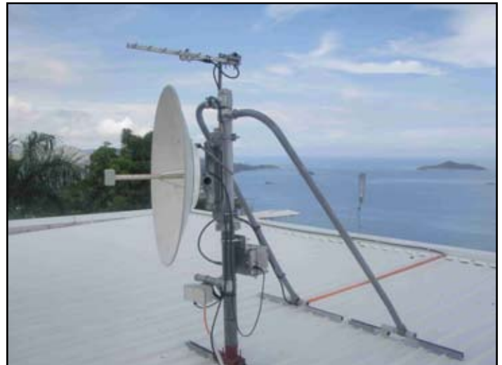
Instalación del repetidor de retorno en uno de los repetidores del sistema de Hitron
